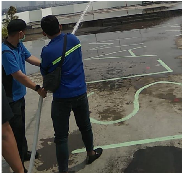
Gambar 2 Pelatihan Penggunaan Pompa Hydrant pada atap Gedung Graha RS Islam Surabaya
